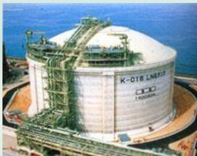
Резервуар хранения газа
